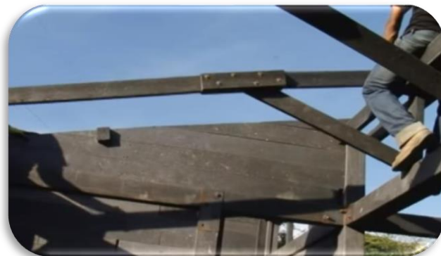
Ilustración 20 - Vigas de cubierta
