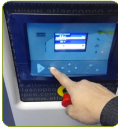
Figura 59. Tablero de control de compresor.
