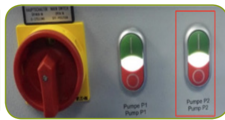
Figura 70. Interruptor de encendido Bomba P2.
