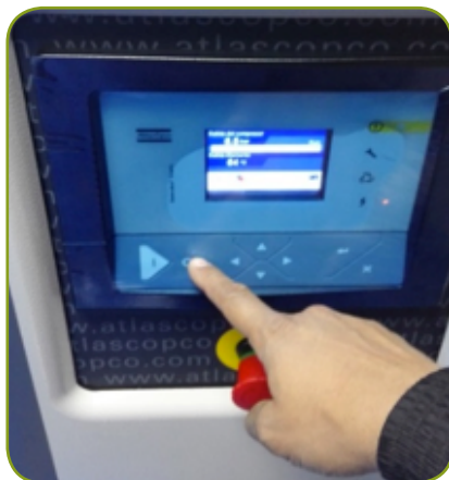
Figura 43. Tablero de control de compresor.
