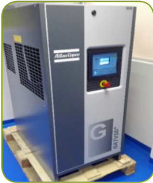
Figura 7. Compresor de tornillo para el suministro de aire comprimido.
