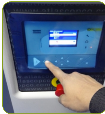
Figura 74. Tablero de control de compresor.
