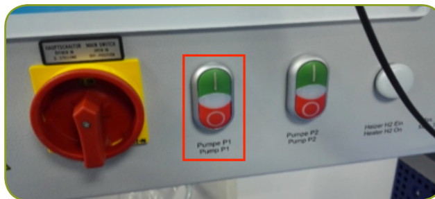
Figura 23. Interruptor de encendido Bomba P1.
