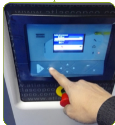
Figura 26. Tablero de control de Compresor.
