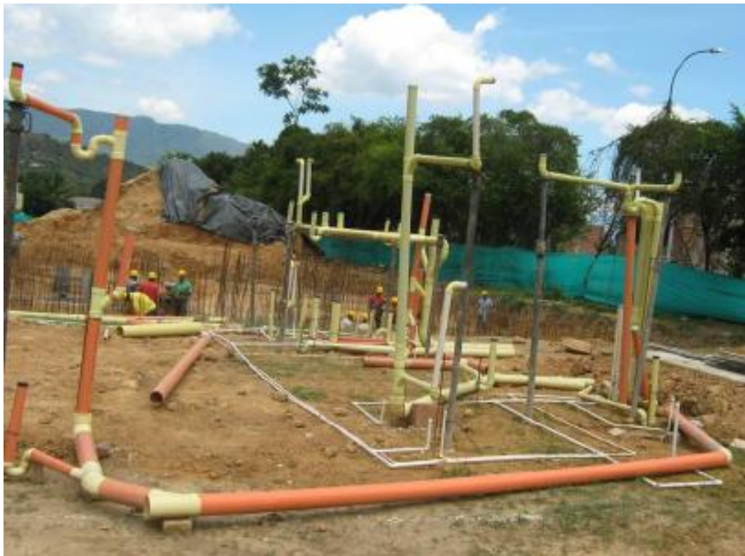
Figura 26 Modulación instalaciones hidrosanitarias
