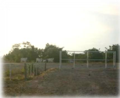
Portón vehicular para ingreso a locaciones
