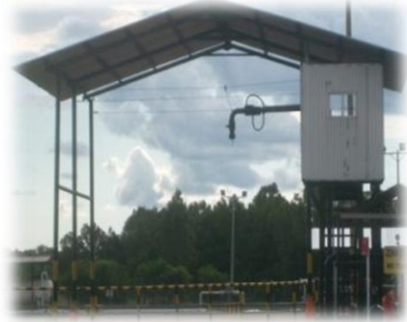
Zona para cargue de crudo
