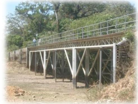
Estructura para puentes
