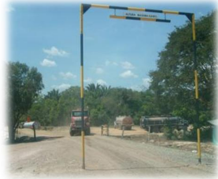
Estructura para delimitación de altura
