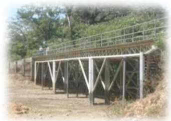
Estructura para puentes
