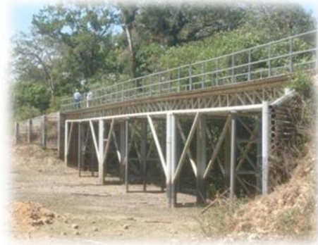
Estructuras para puentes
