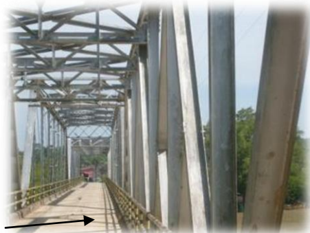
Estructura puente vehicular
