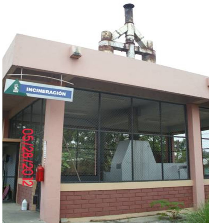
Foto 29. Incinerador del centro hospitalario
