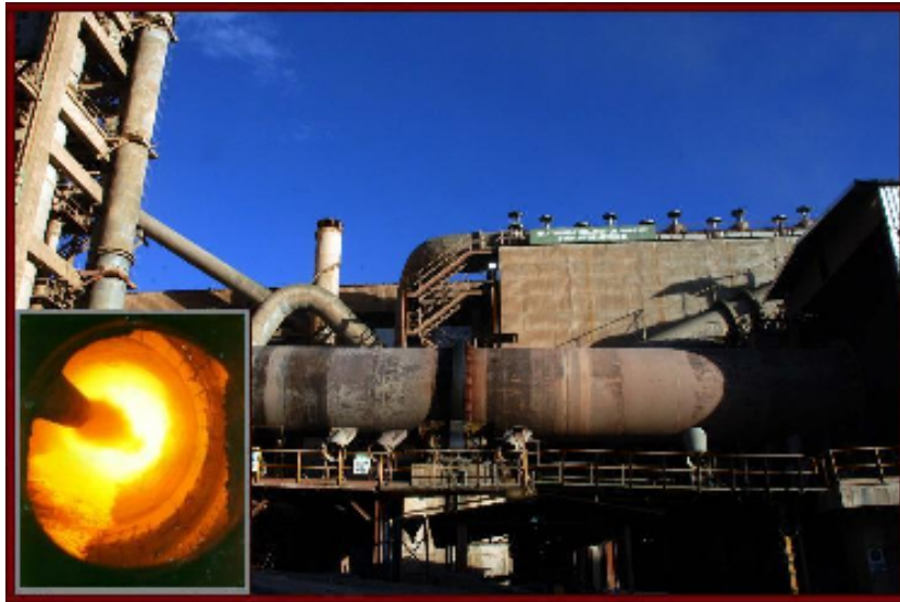
Figura 2 – Horno de la industria cementera (Derecha). Interior del horno donde se puede observar la llama que se utiliza para calcinar el material y producir el clinker, también se puede observar los ladrillos refractarios que protegen la chapa metálica (Izquierda). Imagen extraída de http://www.coboce.com/web/index.php?idsector=3&idlink=72&idsublink=197&nivel=2 .
