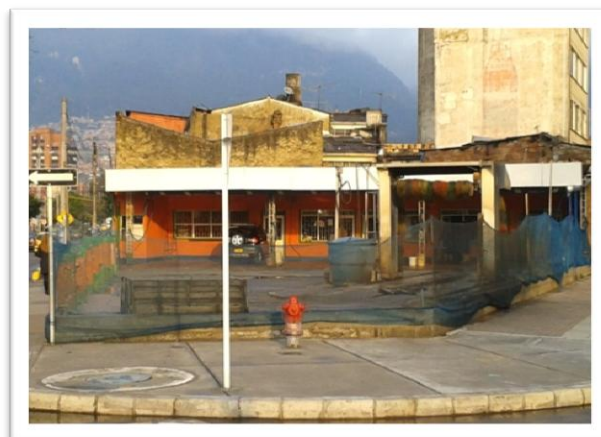
Figura 29. Lavadero de la 45
