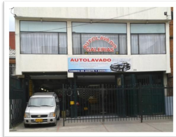
Figura 28. Lavadero de la 52
