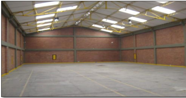
Figura 30. Apariencia física de la planta. Fuente: Autor.
