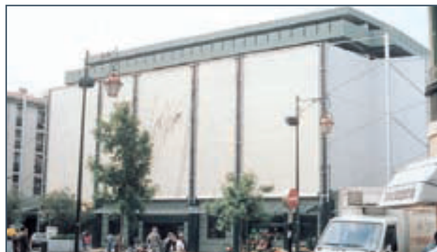
Primera fachada textil realizada en 1994 sobre un aparcamiento aéreo en Aviñón.
