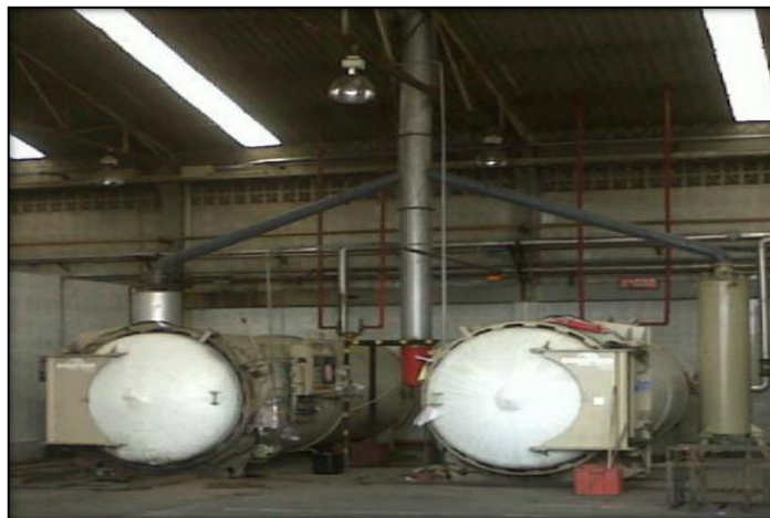
Figura 6. Autoclave de calor húmedo. Fuente (Ecocapital Internacional S.A ESP)
