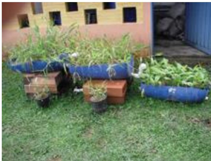
Ilustración 20. Unidades del sistema piloto del humedal artificial
