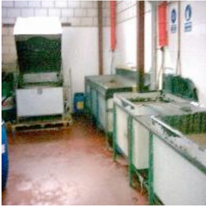
Zona de limpieza de bidones.
