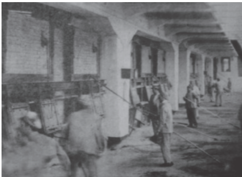
Figura 6.2 Obreros municipales trabajando en la extracción de cenizas y escorias de la cremación de basuras de la usina de Flores
