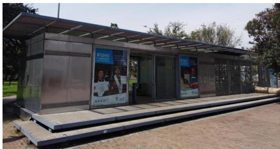
Fotografía 10. Ciclo parqueadero estación de Transmilenio Alcalá de Bogotá (propia, capturada el 20 de marzo de 2019).
