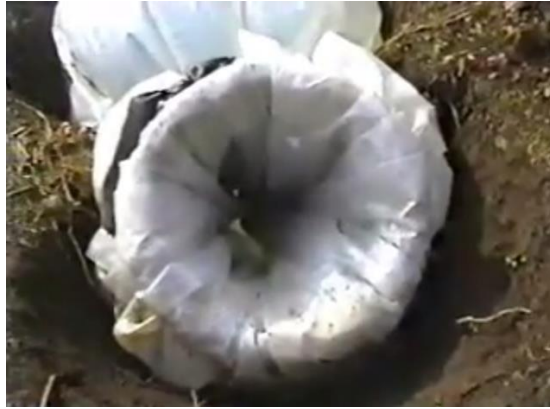
Figura 28. Extremo del polietileno tubular amarrado con correas la caneca plástica.
