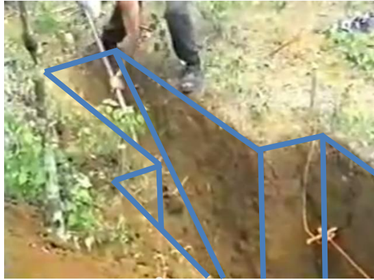
Figura 22. Cárcava conexas al Biodigestor Taiwán o Estructura Flexible
