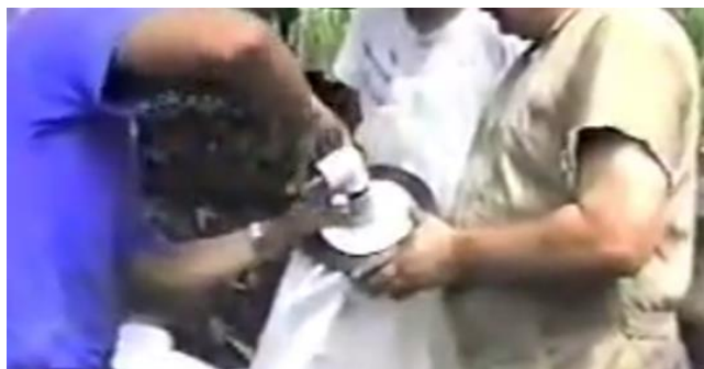
Figura 23. Instalación válvula de salida del Biodigestor Taiwán o Estructura Flexible
