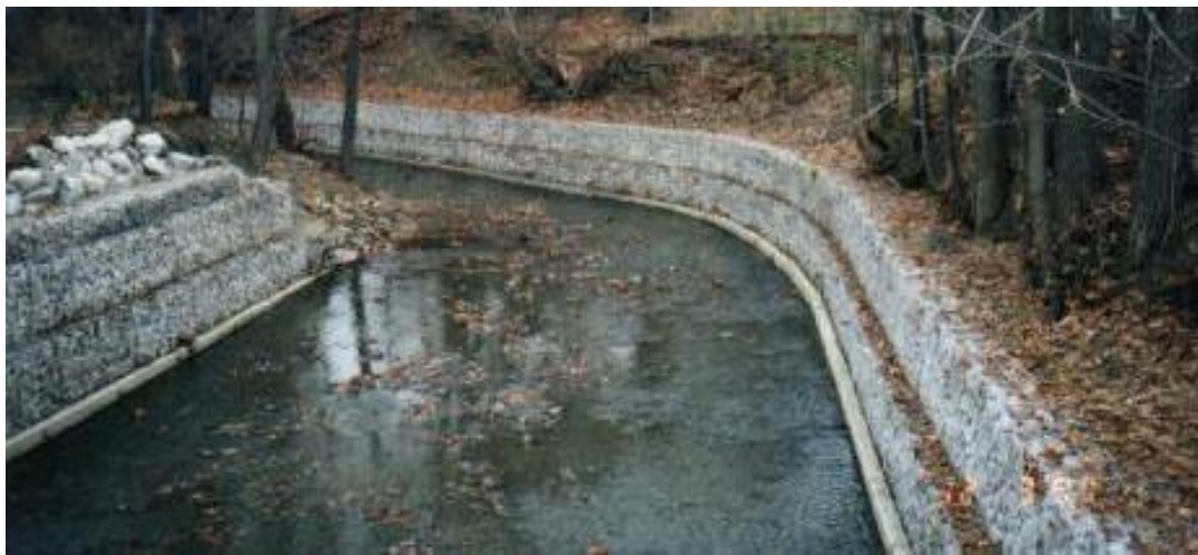
Figura 24 Sistema de la tipología canal verde con gaviones.
