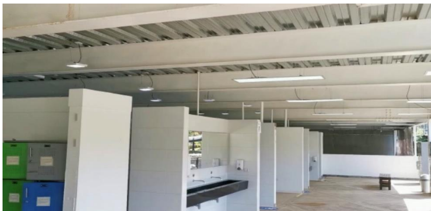
Imagen 7. Estructura interna del Edificio Palmeras.
