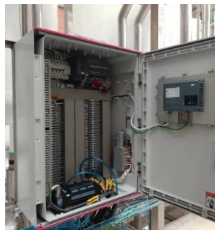
Fig. 7: Tablero para tratamiento de agua
