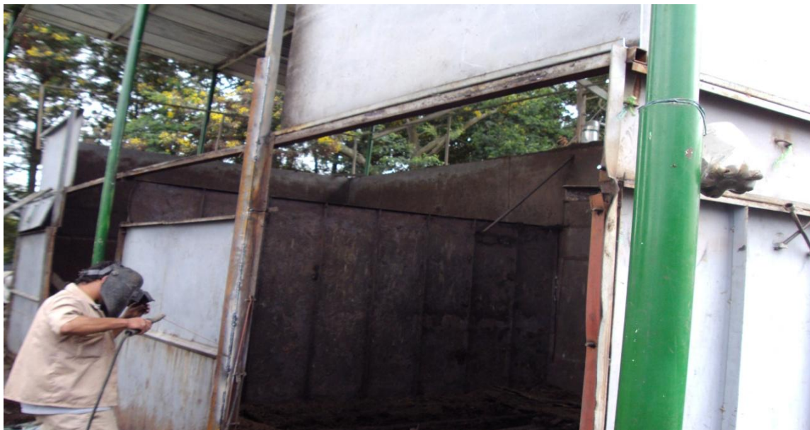
Figura 40 - Cuarto de almacenamiento de la cascarilla de arroz
