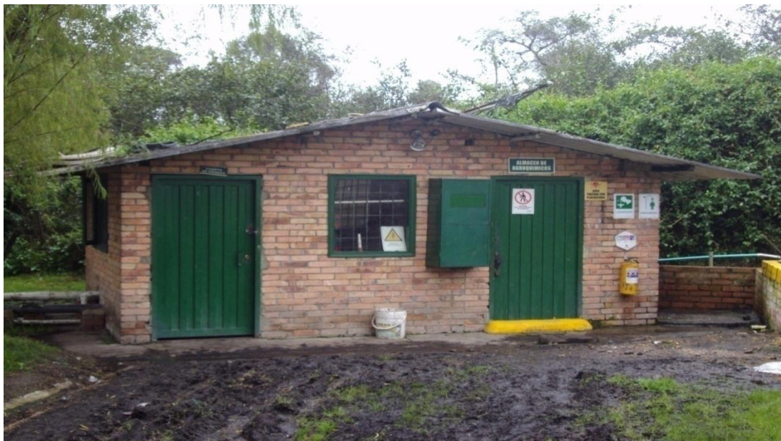
Figura 43 - Estación de Bombas No 3
