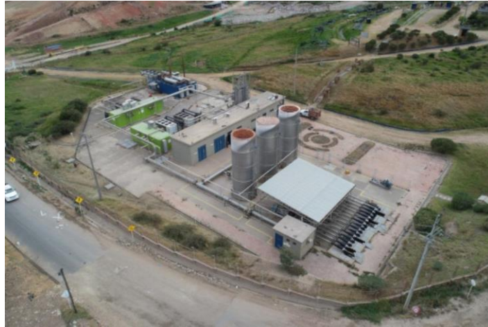
Figura 3. Planta de Biogas Doña Juana
