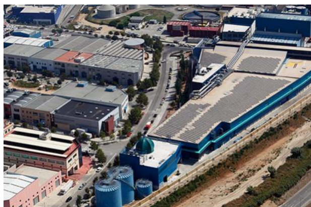
Fuente. Tomado de Centro de Valorización de Residuos del Maresme, por Sacyr Servicios.
