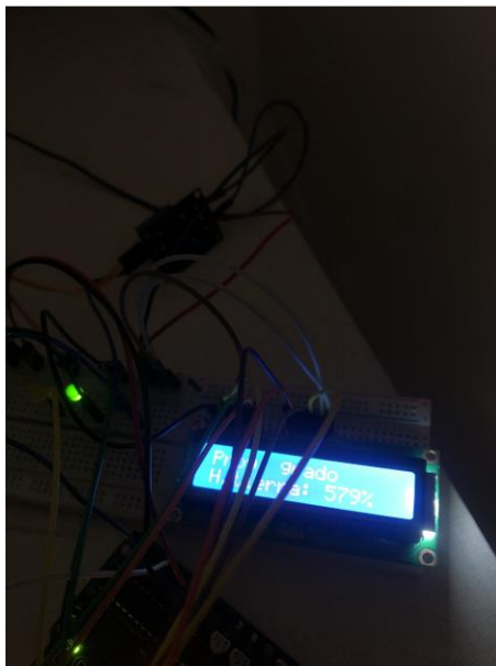
Figura 11: Sistema de detección de humedad.
