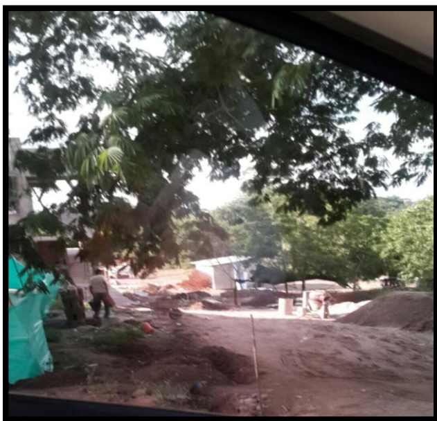
Residuos de obras para nuevo bloque.
