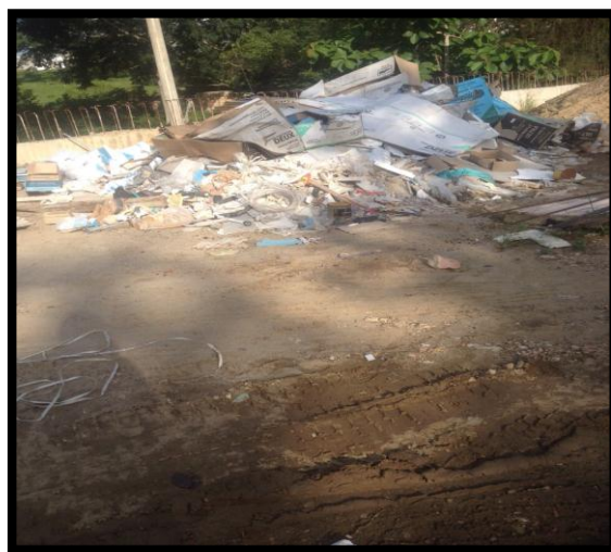
Ilustración 1 Residuos, Escombros remodelaciones laboratorios.
