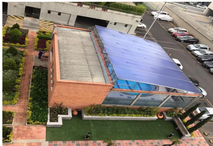
Figura 24 Techo del Vestier de la Piscina. Techo del Vestidor de la Piscina, 53 m 2 . Área de la piscina, 37 m 2 . [Elaboración Propia]
