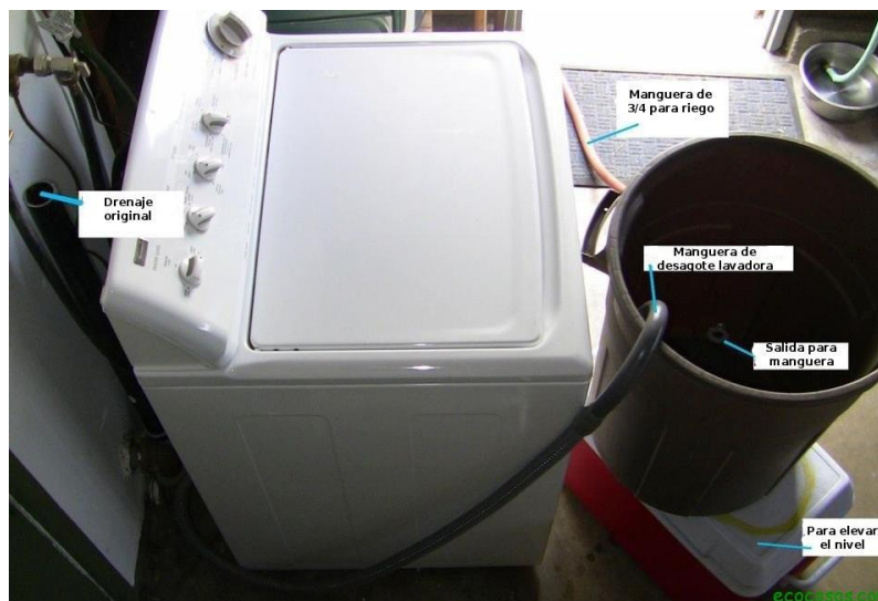
Imagen 3 Método convencional de recuperación de agua. Sistema artesanal baja calidad de aprovechamiento de espacios
