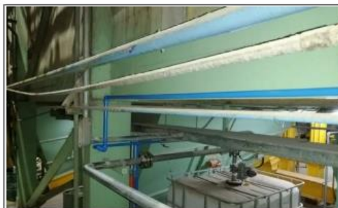
Foto 2 Montaje Líneas Neumáticas LISINA
