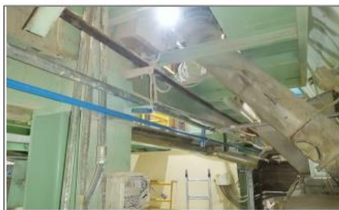
Foto 6 Montaje Líneas Neumáticas LISINA
