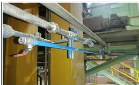
Foto 8 Montaje Líneas Neumáticas LISINA
