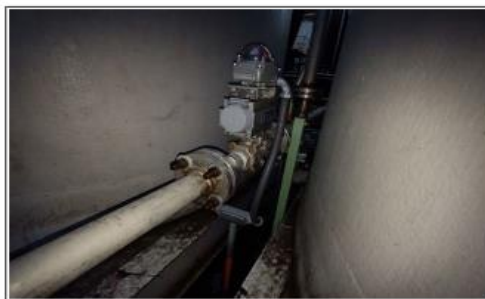
Foto 8 Montaje de Facilidades electricas para Dosificacion Lisina
