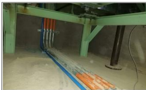
Foto 4 Montaje Líneas Neumáticas LISINA
