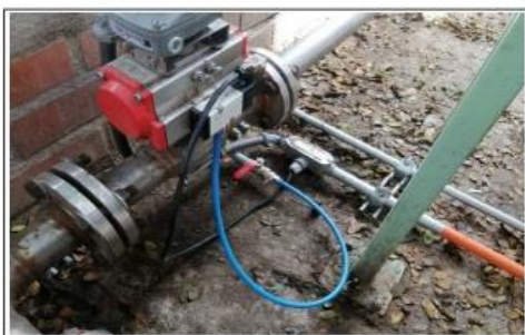
Foto 11 Montaje Líneas Neumáticas LISINA
