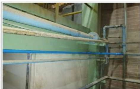
Foto 1 Montaje Líneas Neumáticas LISINA
