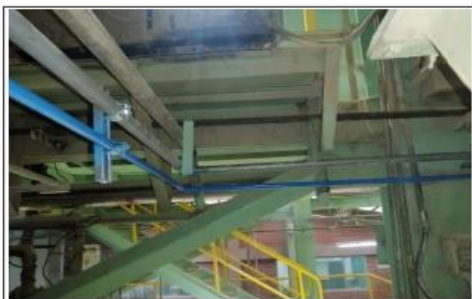
Foto 7 Montaje Líneas Neumáticas LISINA
