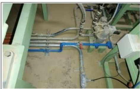
Foto 5 Montaje Líneas Neumáticas LISINA
