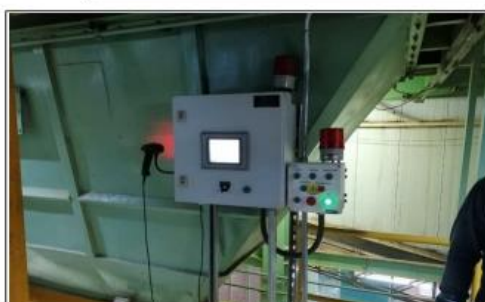
Foto 16 Montaje facilidades electricas Malacate Micros
