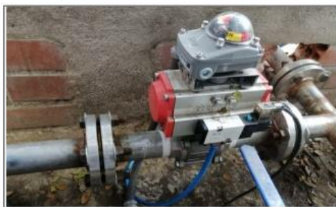
Foto 12 Montaje Líneas Neumáticas LISINA
