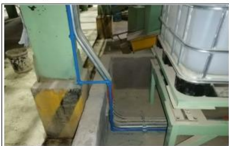
Foto 3 Montaje Líneas Neumáticas LISINA
