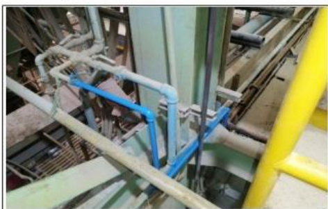
Foto 9 Montaje Líneas Neumáticas LISINA
