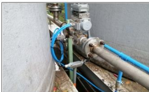
Foto 10 Montaje Líneas Neumáticas LISINA
