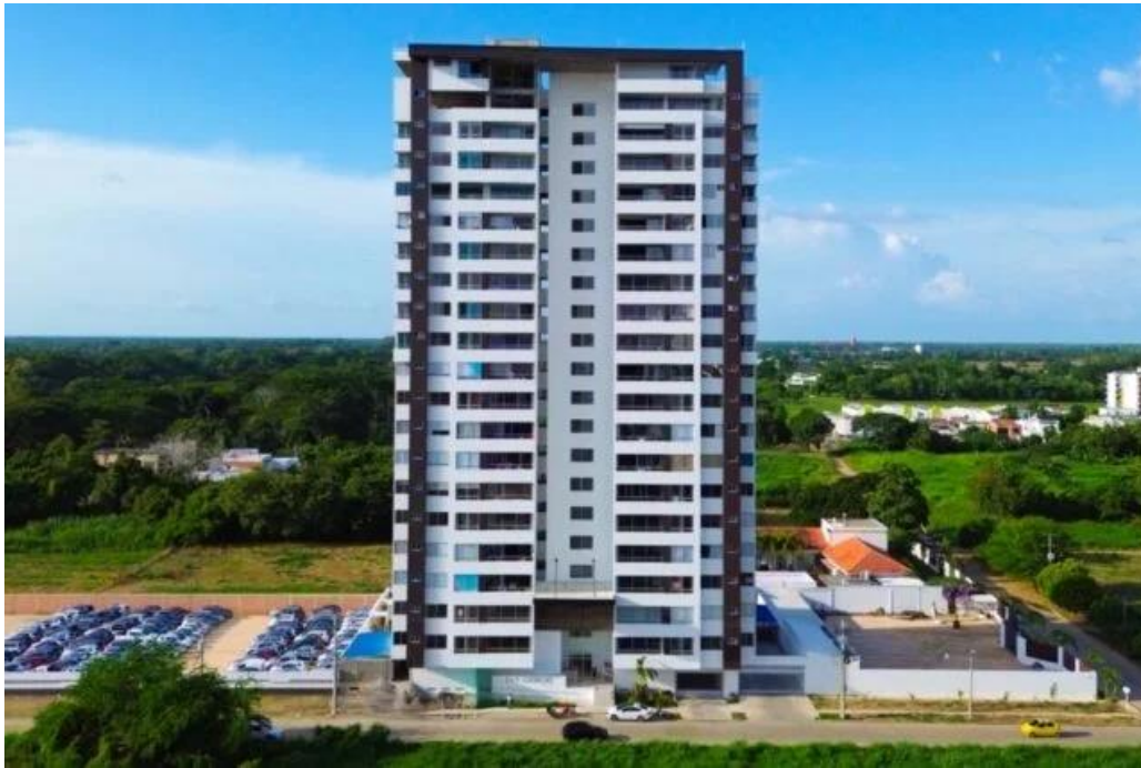
Figura 19. Edificio San Giorgio. Fuente: AlCielo Constructora S.A.S.
