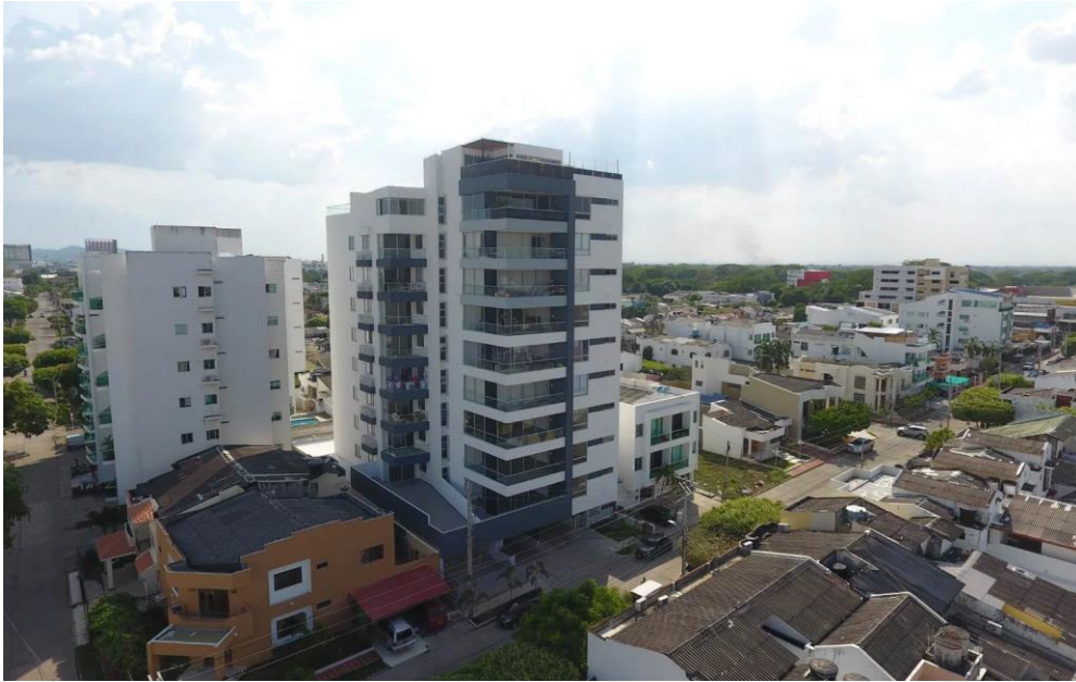
Figura 21. Edificio K62 Fuente: AlCielo Constructora S.A.S.
