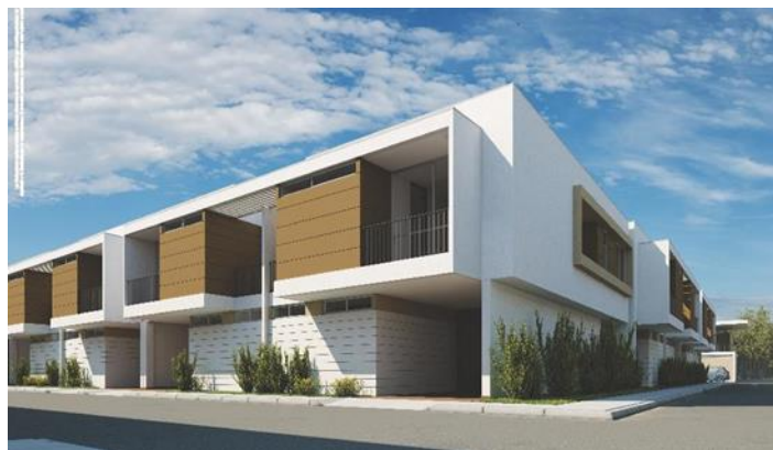
Figura 9. Modelo de casas del conjunto. Fuente: AlCielo Constructora S.A.S.
