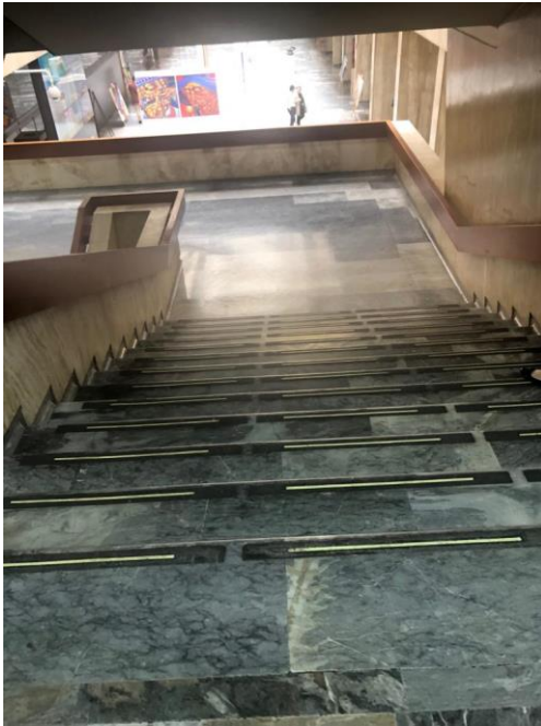
Figura 22 Escaleras con cintas antideslizantes
