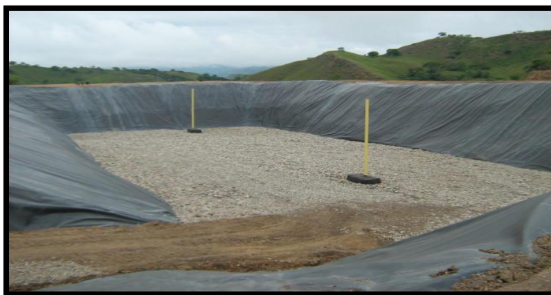
Foto No 44 Chimenea extracción de gases
