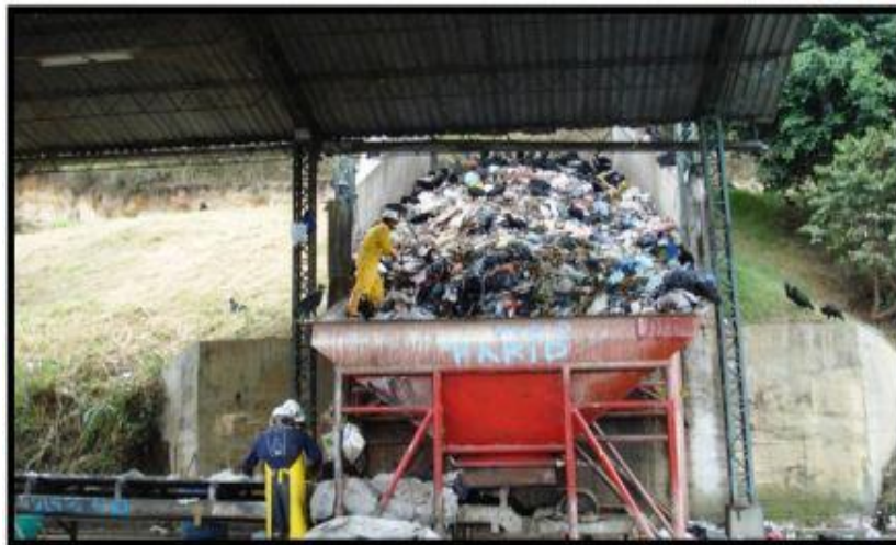
Foto No 41 Rampa de descargue
