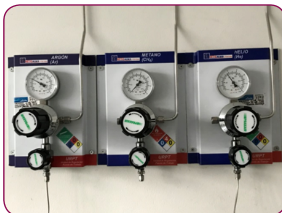
Figura 72. Verificación de la presión de los gases.
