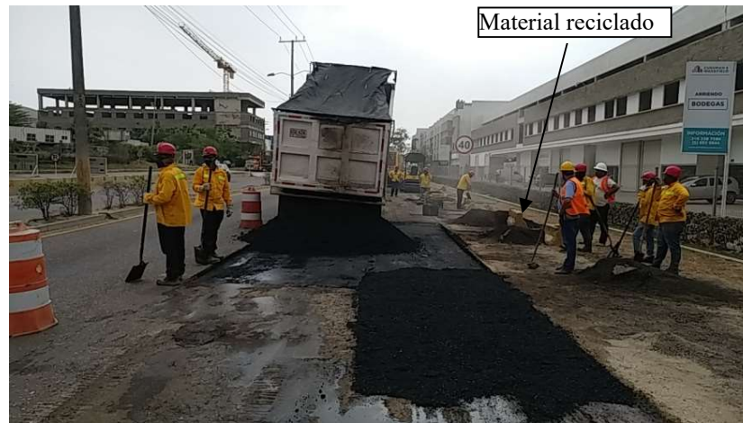
Figura 26. Mantenimiento vial con parcheos
