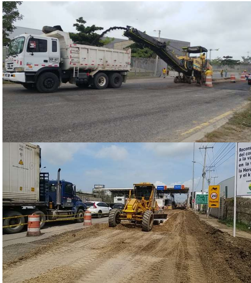
Figura 29. Fresado pavimento y reutilización en relleno seleccionado
