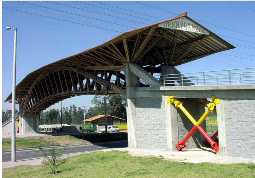
Ilustración 15. Puente Guadua Bogotá - Calle 80
