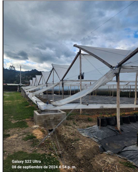
Ilustración 2. Sistema de recolección de aguas lluvia en finca Villa María.
