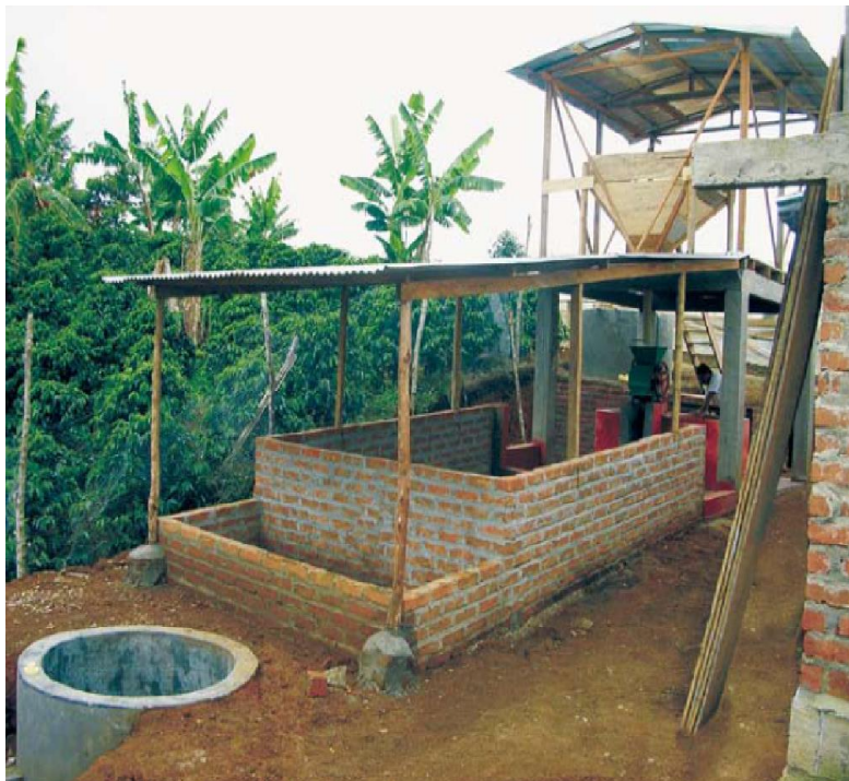
Figura 14. Construcción de un beneficiadero de café
