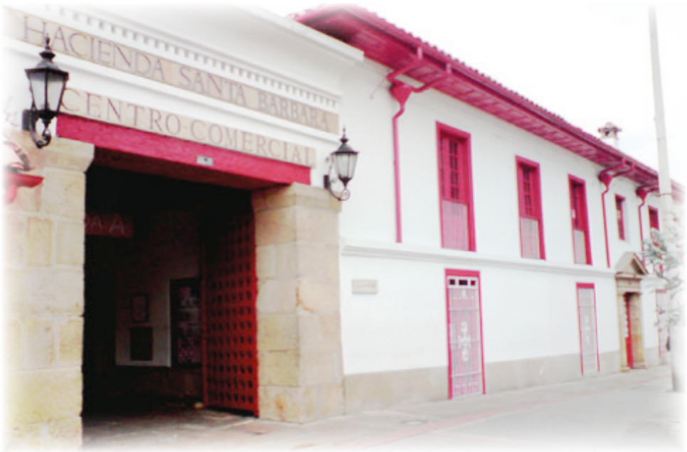
Figura 6. Foto Centro Comercial Hacienda Santa Bárbara Fuente. http://portel.bogota.gov.co
