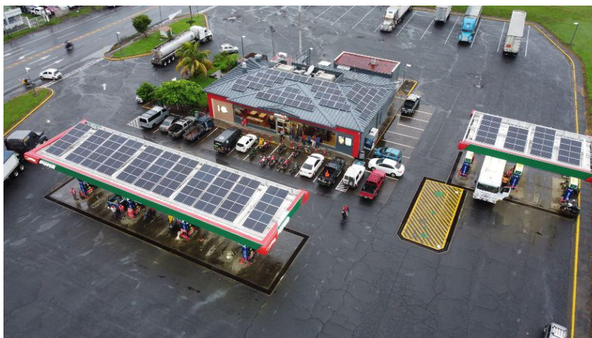
Figura 6. Estación de servicio de distribución de combustible con operación por energía solar.
