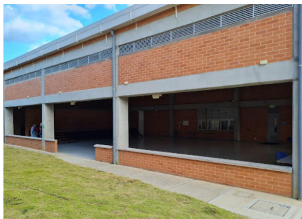
Ilustración 6 Fotografías de la Estructura Bloque 1 “Laboratorios”.
