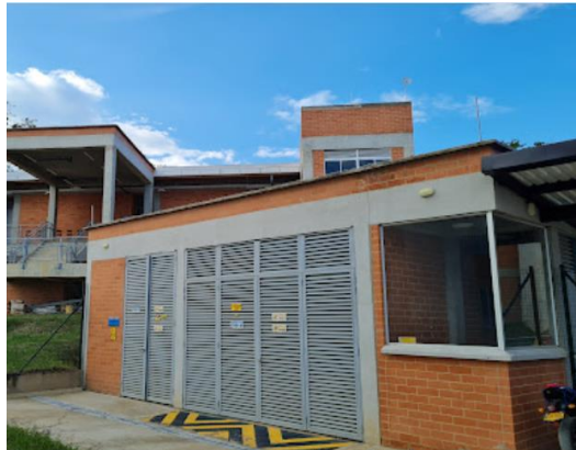
Ilustración 10 Fotografías de la Estructura Bloque 5 “Portería”.
