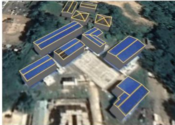
Ilustración 23 Panorámica de los techos de las edificaciones
