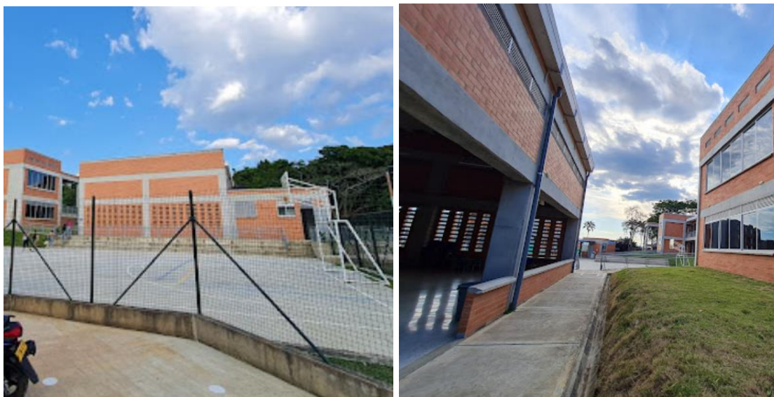
Ilustración 8 Fotografías de la Estructura Bloque 3 “Comedor”.
