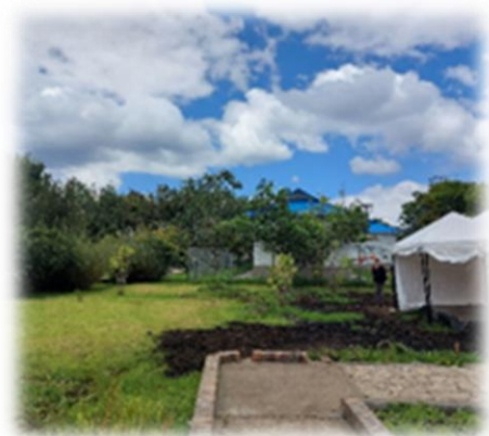
Infraestructura temporal ubicada en el Jardín
