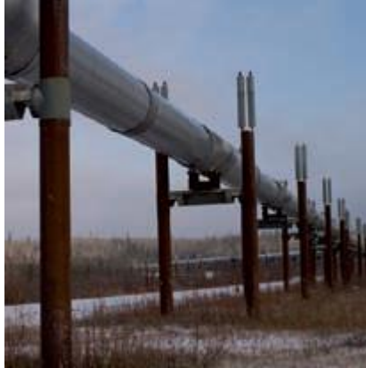
Fig 7. Transporte de crudo pesado con tubo recubierto
