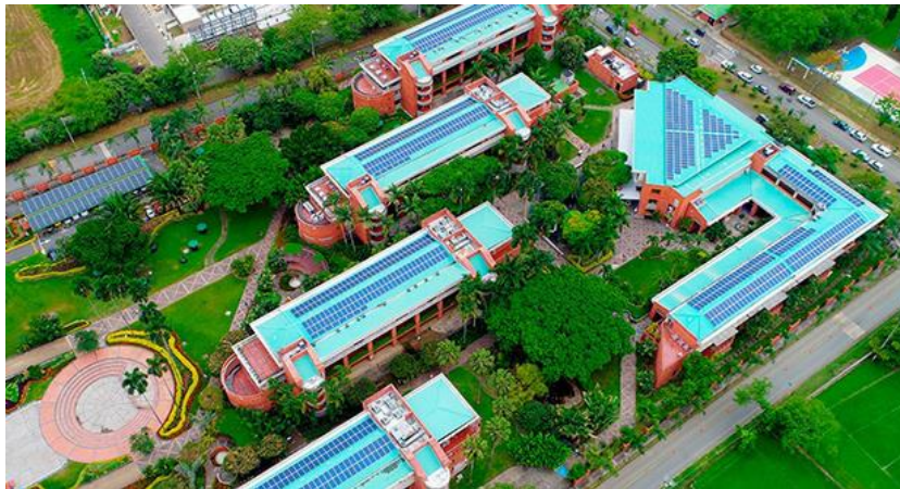
Figura 7. Instalación solar Universidad Autónoma de Occidente de Cali. Fuente Página web Celsia
