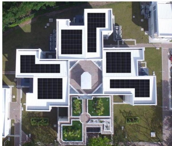
Figura 6. Instalación Solar Electrohuila S. A E.S.P. Fuente PV magazine
