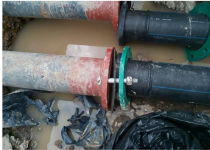
Figura 2: Inconveniente Topográfico, Av. Las Villas con calle 134 en Bogotá D.C. Tubo de hierro dúctil y polietileno encontrada – elaboración propia.
