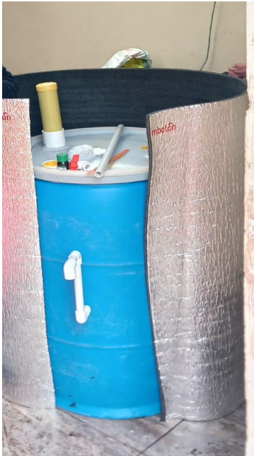
Imagen N1 Biodigestor en instalación
