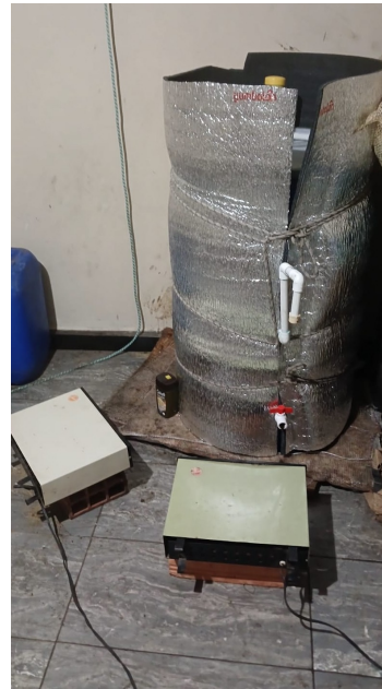
Imagen N2 Biodigestor en adaptación - Calor
