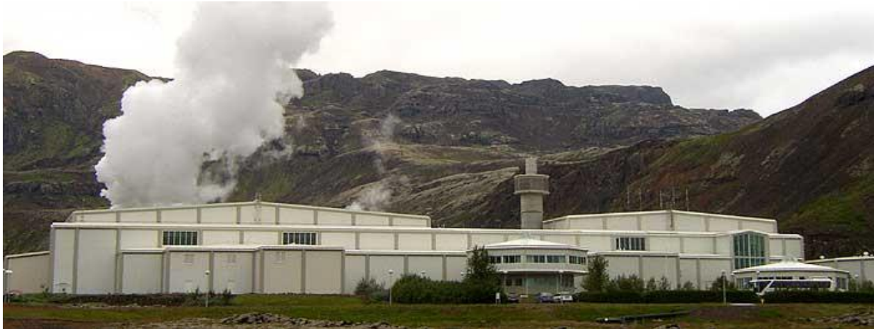
Figura 7 Edificio principal de la Central Geotérmica de Nesjavellir. (Guðmunsson, 1996,2002,2005)
