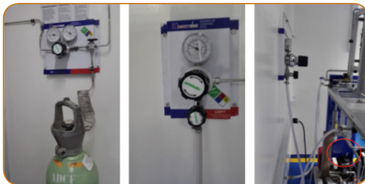
Figura 11. Instalación y suministro de \text{CO}_2 .
