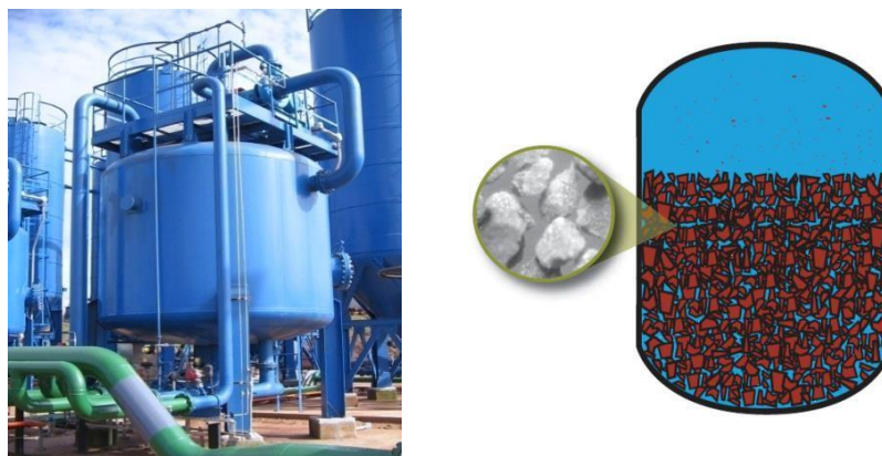
Figura 8.5.2 Filtros de cascarilla de nuez, Fuente: los autores
