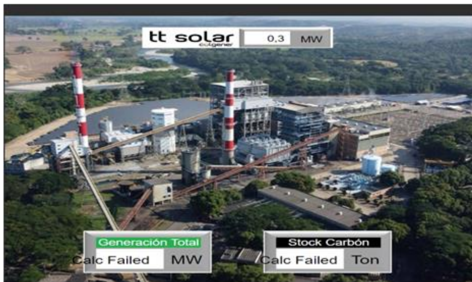
Ilustración 3. Planta de Termotasajero Dos Solar S.A. E.S.P. en operación.
