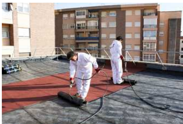
Figura 31. Cuadrilla impermeabilizando (Aislamientos la mancha, 2011)
