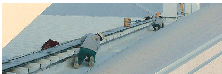
Figura 22. Inspección a la impermeabilización (AINUR, 2011)
