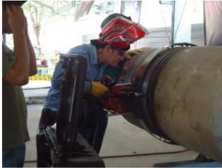
Figura No. 38. Soldadores instalando las máquinas orbitales y preparando la tubería para ser soldada, Oleoducto Bicentenario, (2012).
