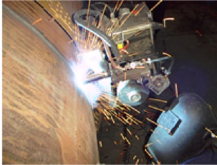
Figura No. 35. Movimiento ascendente de la maquina orbital, SICIM Colombia, presentación OBC, (2011). p. 14
