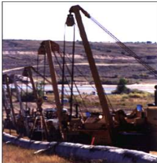
Figura No. 40. Equipo grúas de montaje lateral (tendido de la tubería). IPL TECHNOLOGY, pdf, (1995). p. 21
