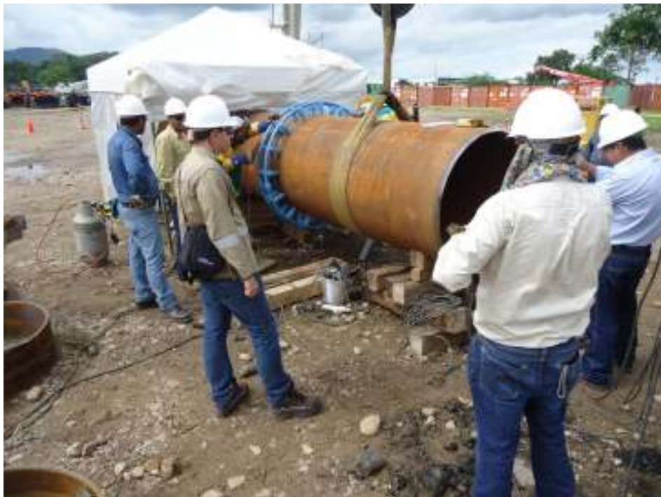
Figura No. 54. Preparación de la tubería para ser soldada automáticamente, Oleoducto Bicentenario, (2011). p. 3
