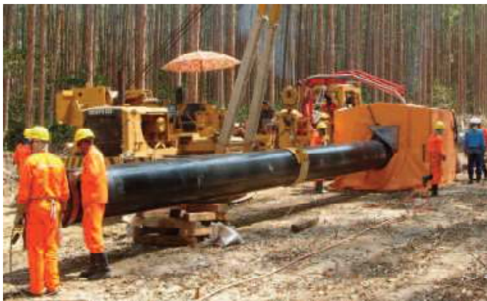
Figura No. 1. Alistamiento de tubos para ser soldados. Dyna Torque Technologies Inc. (2011) presentación, PDF, p.13
