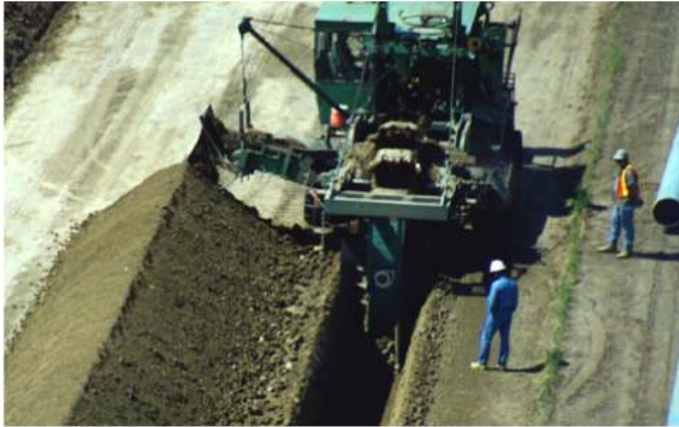
Figura No. 41. Zanjadora abriendo el terreno para el tendido de la tubería. IPL TECHNOLOGY, pdf (1995), p 35
