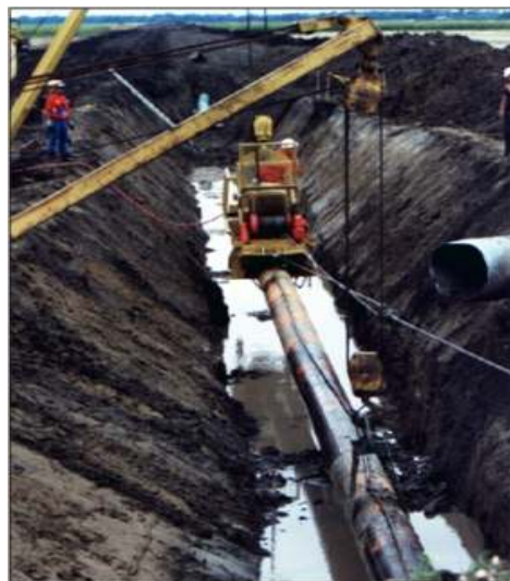
Figura No. 43. Máquina de perforación horizontal (cruce subfluvial). IPL TECHNOLOGY, pdf, (1995). p. 23
