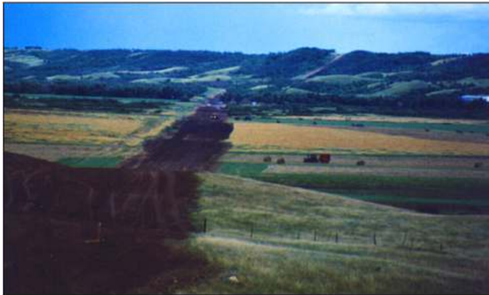
Figura No. 37. Cruce Trazado y adecuación del terreno para la construcción. IPL TECHNOLOGY, pdf, (1995). p. 47
