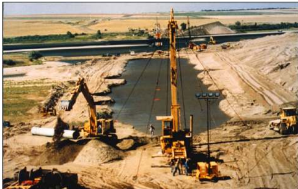
Figura No. 36. Cruce del oleoducto por debajo de un rio (posible impacto ambiental). IPL TECHNOLOGY, pdf (1995). p. 55
