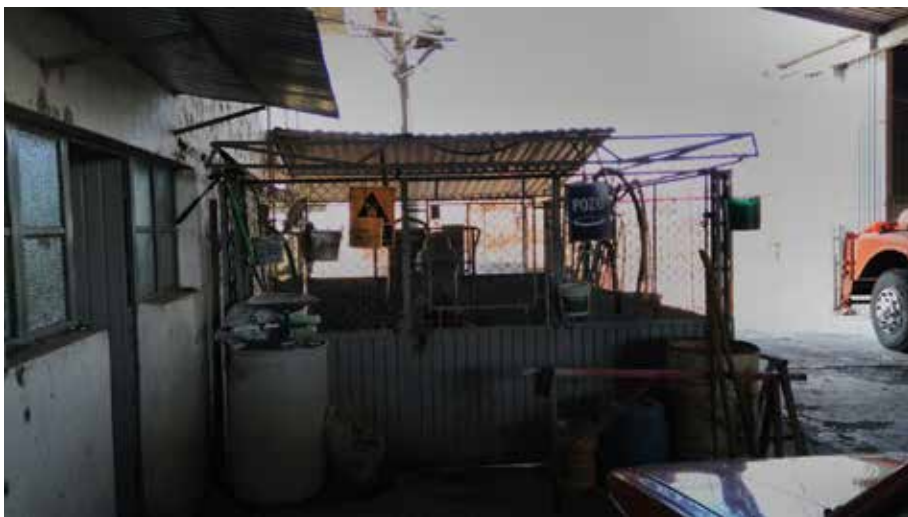
Imagen 9. Instalación del pozo de riego.
