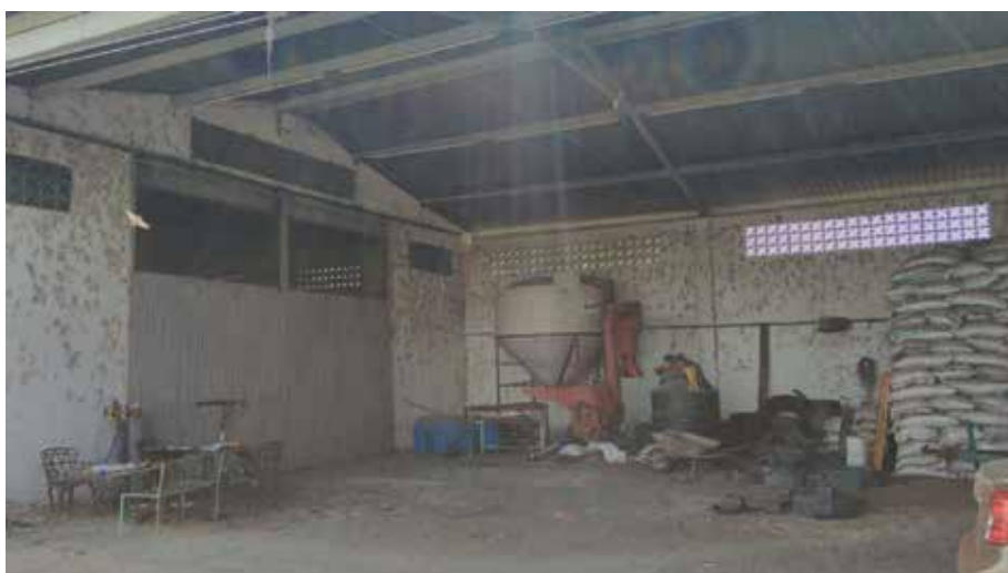
Imagen 4. Patio de operaciones y puerta de almacén de maquinaria, herramientas e insumos.
